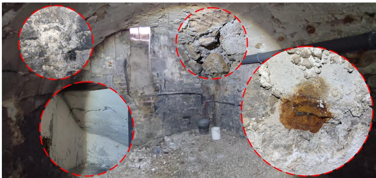
Focus et localisation des pathologies visibles au niveau de la seconde salle des caves.
