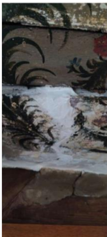
Détail rebouchage avec enduit
