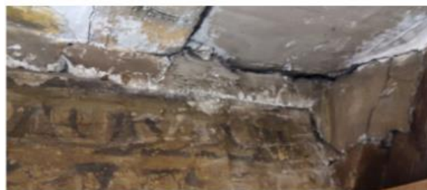
Détail usures et fissures au plafond
