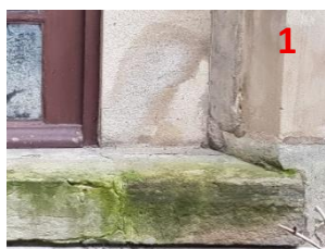
Fissures, humidité, colonisation biologique
