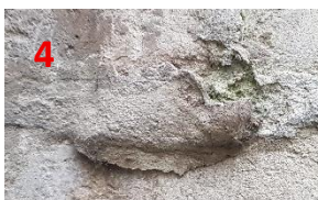
Boursoufflement et pulvérisation
