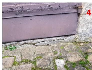
Fissuration de l'enduit ciment, éclats de la peinture, mousse
