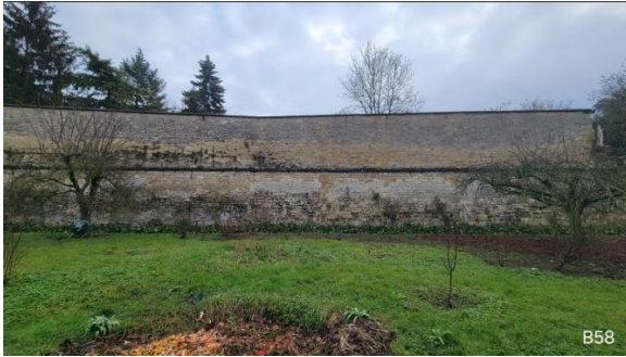
Diverses campagnes de mortier avec pertes + assombrissement de la pierre dû à l'humidité
