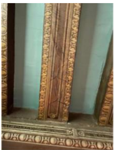
Détail fissures sur la poutre en bois
