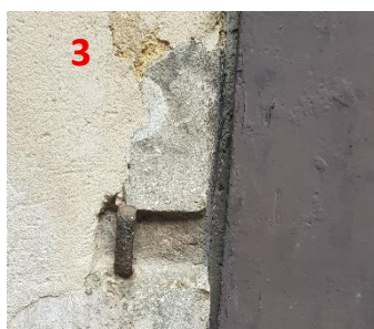
Enduit ciment de réparation
