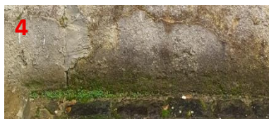
Remontées capillaires, colonisation biologique, joints ciment au sol
