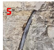
Manque de joint, tuyau apparent
