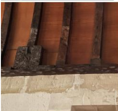
Assemblage bois avec les traces des outils des charpentiers.
