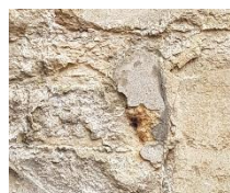
Desquamation et fer rouillé
