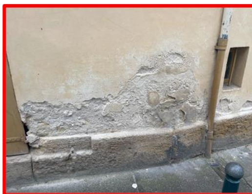
Éclatement de tuiles, fissures au niveau de la corniche et remontée de sels sur les façades
