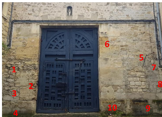
Manque de joint, tuyau apparent
