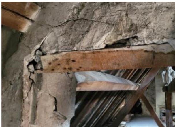
Effondrement de linteau et de sa remontée dans le grenier de l'aile, photographie personnelle, 2025.
