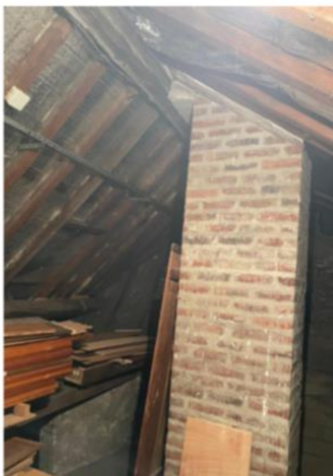
Dalle en ciment, charpente en chêne, habillage en lambris.
