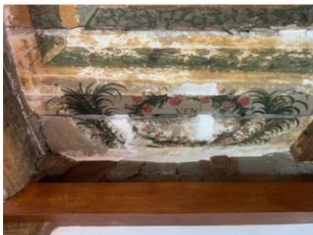
Détail lacunes et usures au plafond
