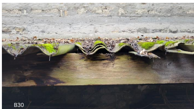
Colonisation végétale (mousse) + assombrissement du bois dû à l'humidité
