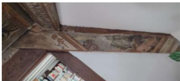
Détail décor peint sur la poutre et rebouchage avec enduit patiné
