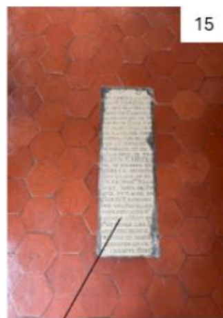
Sol en tomette avec conservation d'une ancienne dalle gravée.
