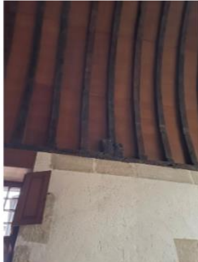
Assemblage bois avec les traces des outils des charpentiers.
