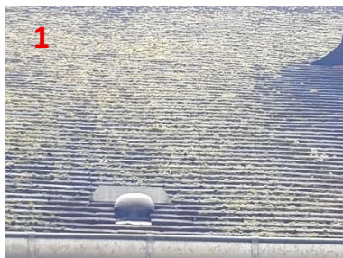
Mousse sur les tuiles
