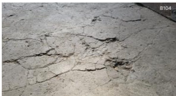
Fissuration de la chape de béton / grenier de l'Aile de la Reine, photographie personnelle, 2025.
