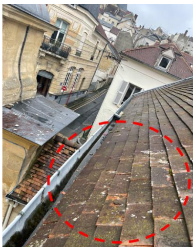
Éclatement de tuiles, fissures au niveau de la corniche et remontée de sels sur les façades
