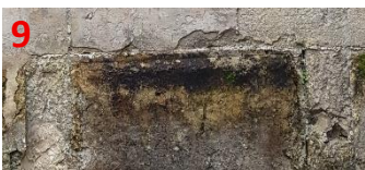
Remontées capillaires, croutes noires et éclats, desquamation
