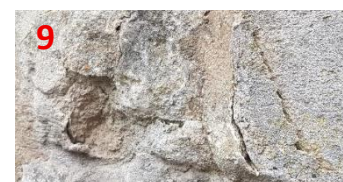
Eclats de la pierre, boursoufflement et pulvérisation
