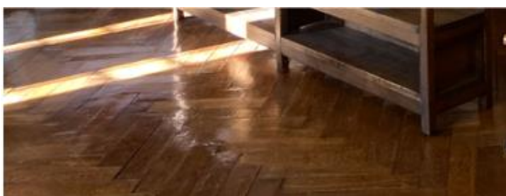
Pose à bâtons rompus, salle du chapitre
