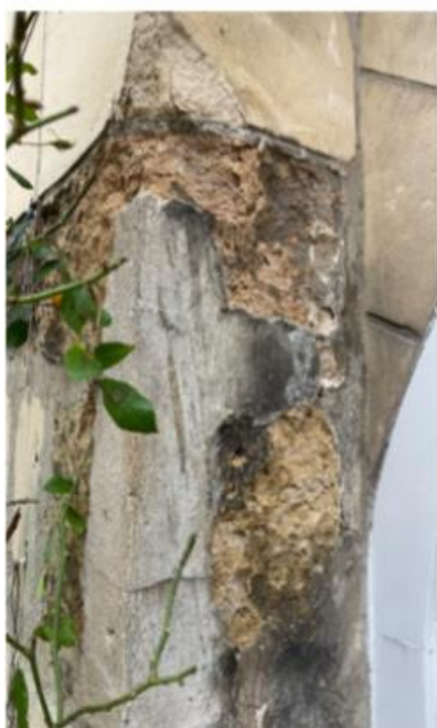
Perte de matière, fissure et ciment.
