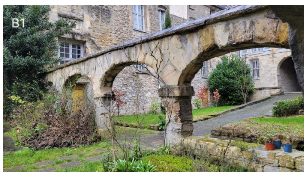
Assombrissement dû à l'humidité et encroutement.
