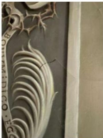
Détail décollement peinture sur le mur
