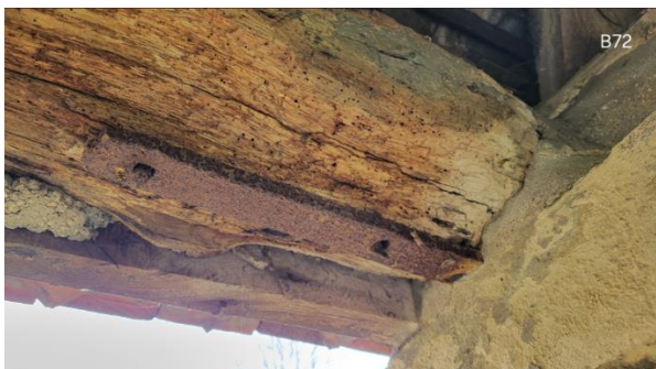
Attaques d'insectes + corrosion
