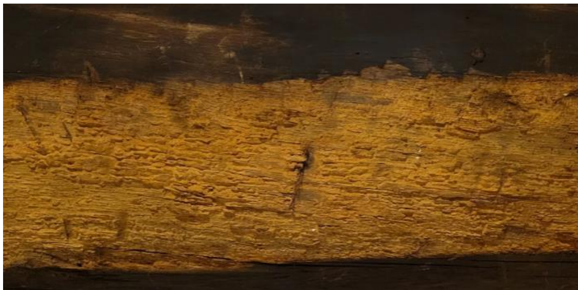
Pourriture fibreuse observée à proximité de l'Office des Alpocrates au Rez-de-Chaussée de l'aile, photographie personnelle, 2025.
