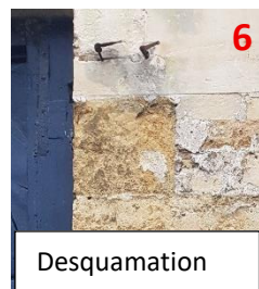
Manque de joint, tuyau apparent
