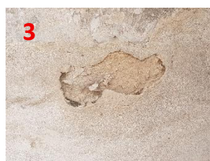
Boursoufflement, pulvérisation
