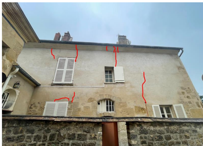
Éclatement de tuiles, fissures au niveau de la corniche et remontée de sels sur les façades
