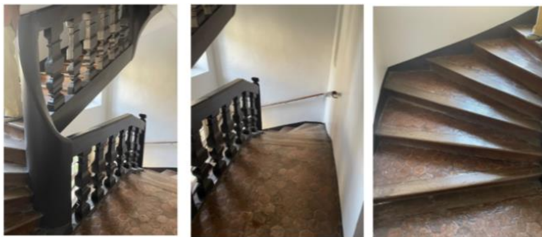
Escalier mise aux normes par le rajout d'une rampe sur le mur.
