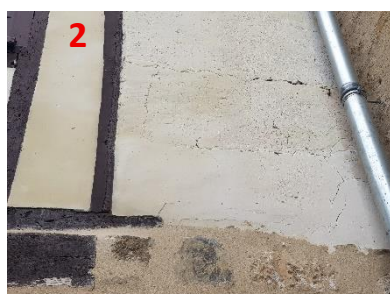
Fissuration du plâtre
