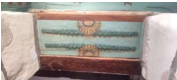
Détail lacunes et usures, ébrasement porte
