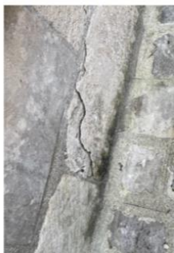
Desquamation de la pierre (sur le soubassement)
