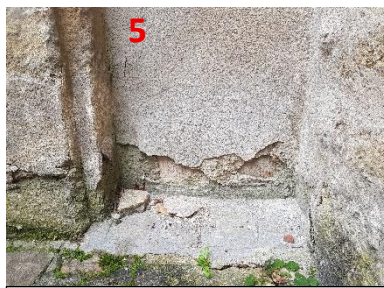
Décollement de l'enduit, fissures
